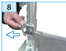
Retirer les taquets à chaîne
