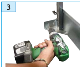
Fixer la balustrade sur le toit de cabine (tôle ép. 4mm mini) de chaque côté avec des écrous M8
